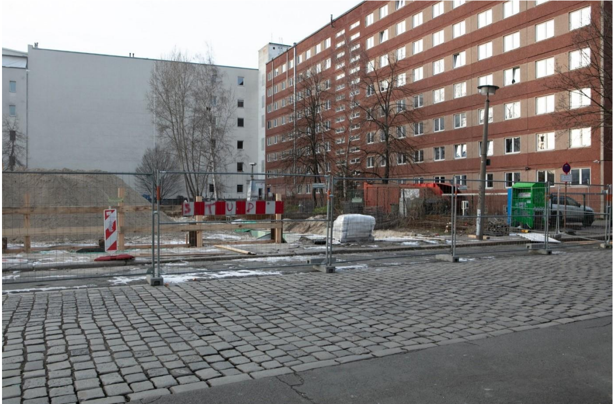
Baustellenansicht, Adalbertstraße, Foto: Cleo Wächter, Februar 2023
