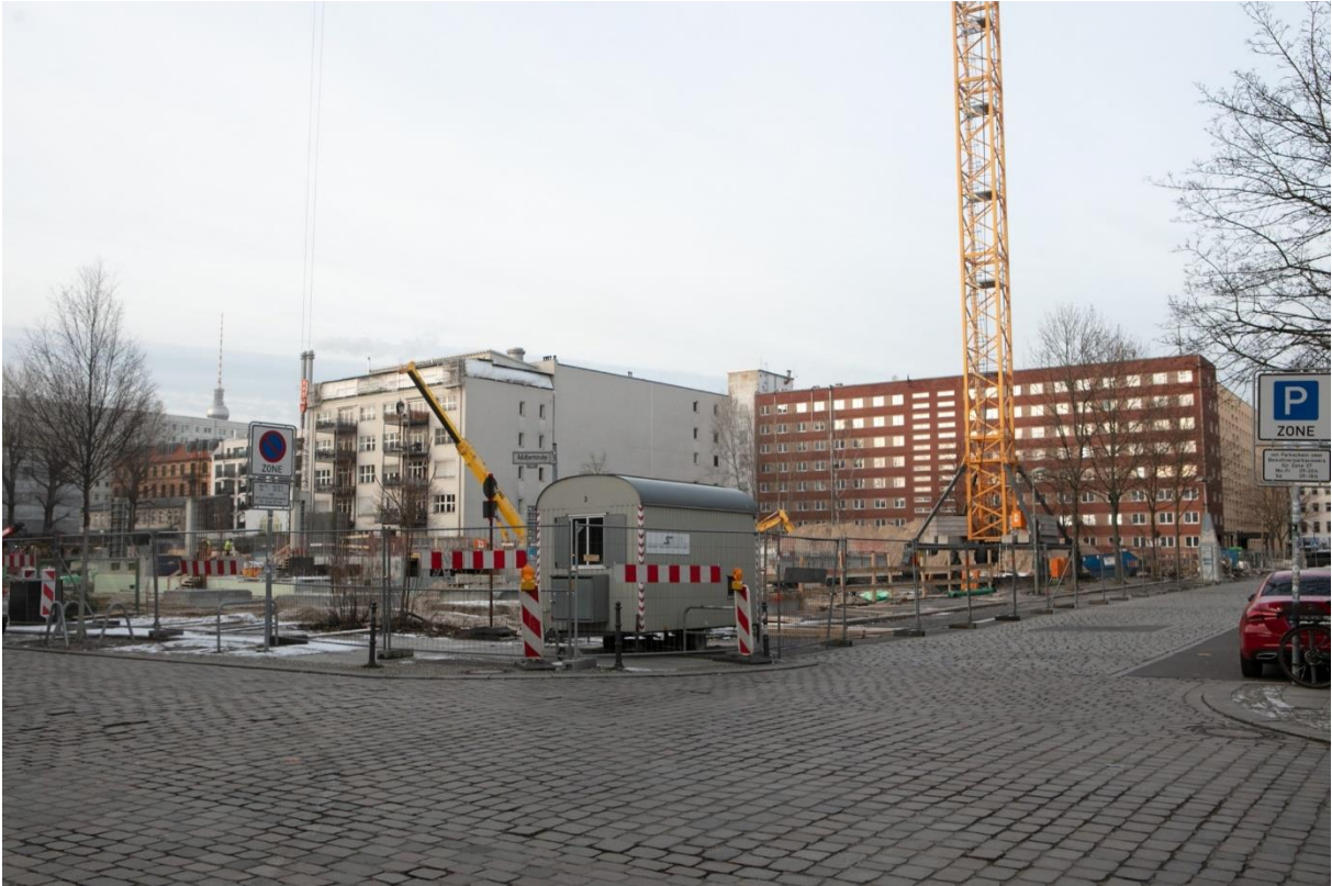
Baustellenansicht, Adalbertstraße/ Ecke Melchiorstraße, Foto: Cleo Wächter, Februar 2023
