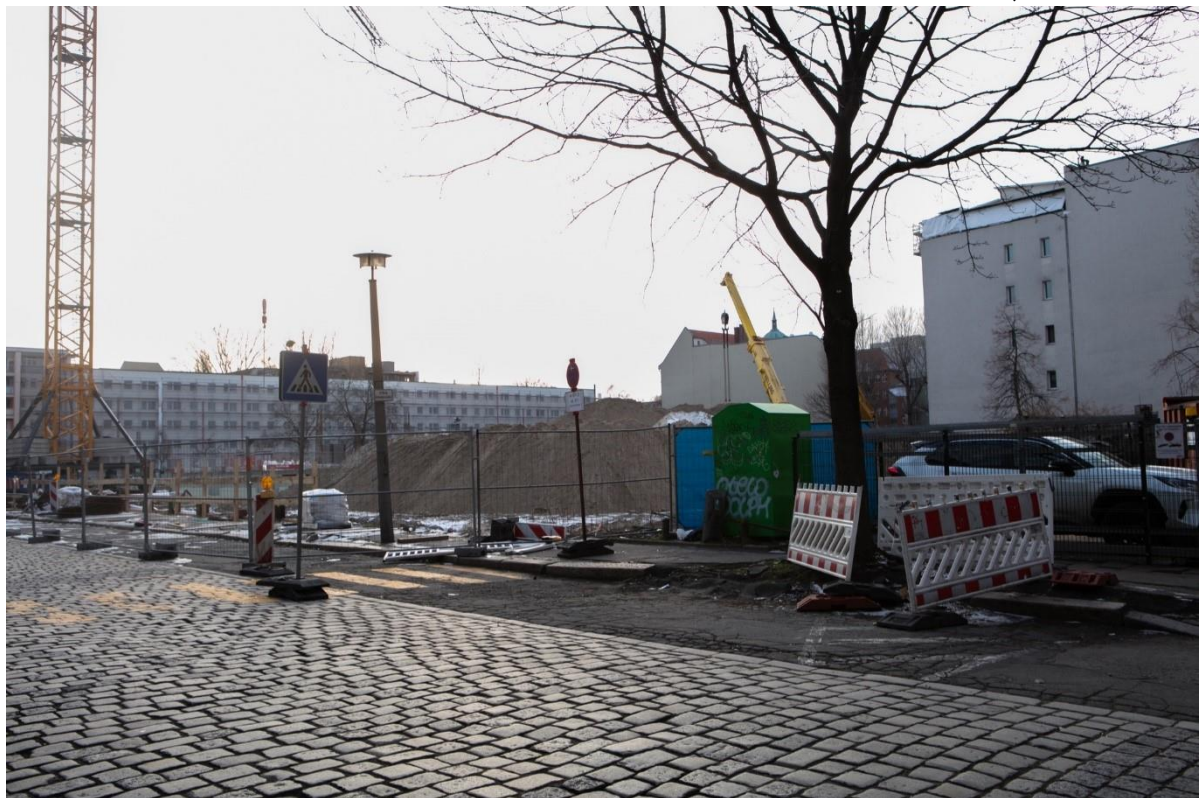
Baustellenansicht, Adalbertstraße, Foto: Cleo Wächter, Februar 2023
