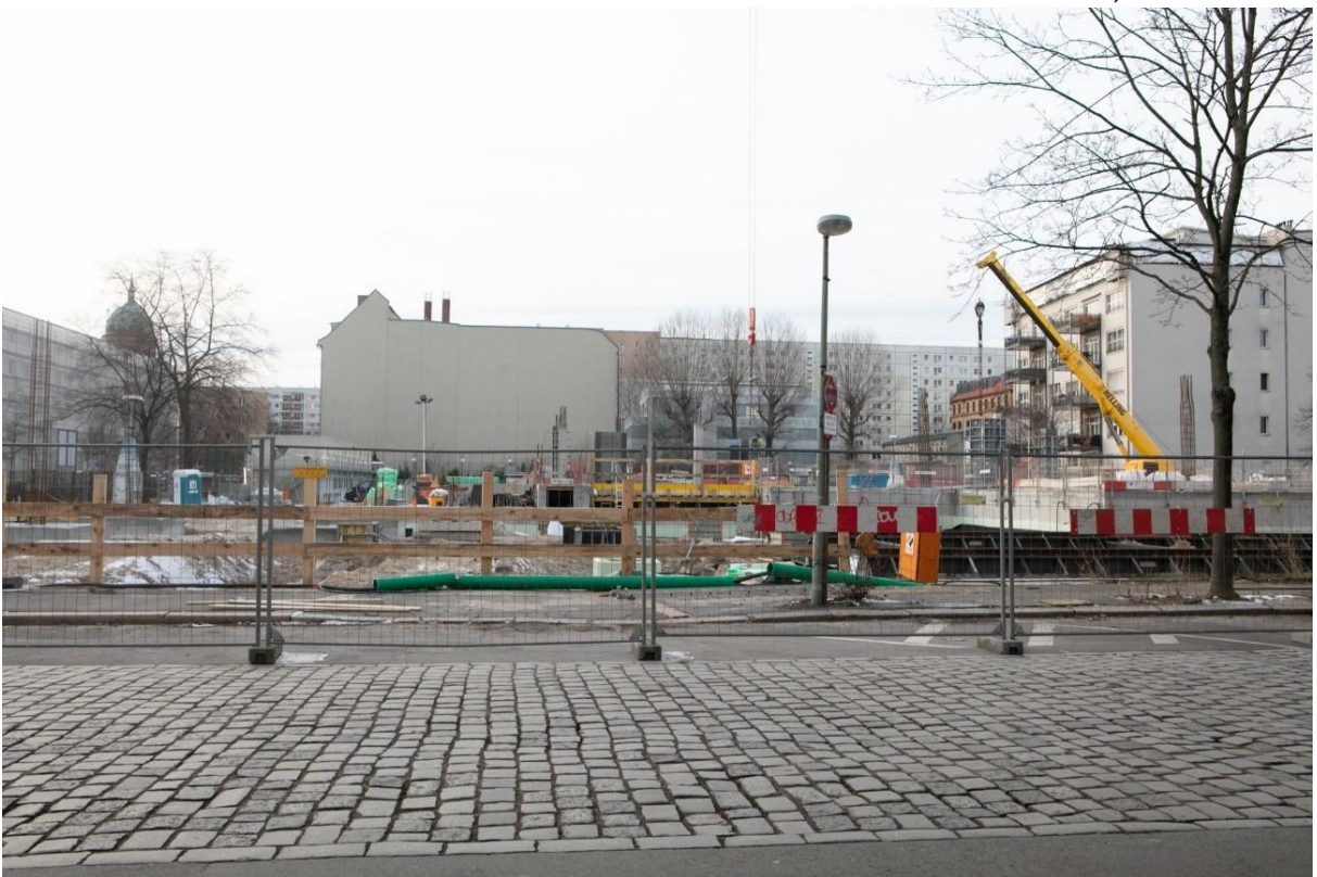
Baustellenansicht, Adalbertstraße, Foto: Cleo Wächter, Februar 2023
